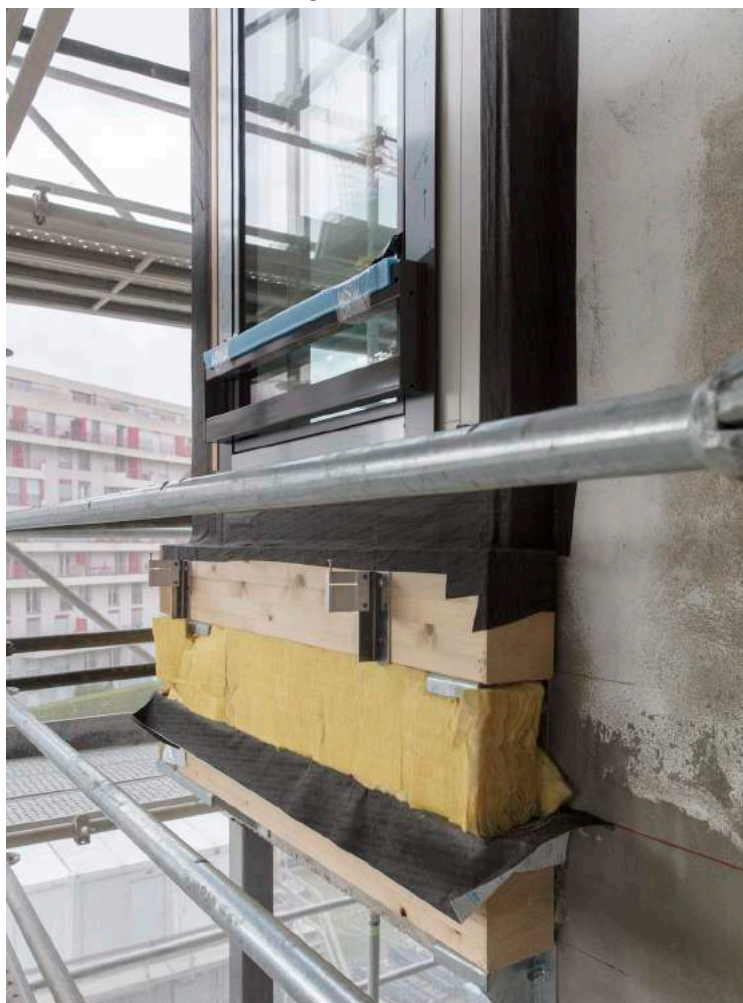
Installation de fenêtres à double vitrage aux Minoteries
